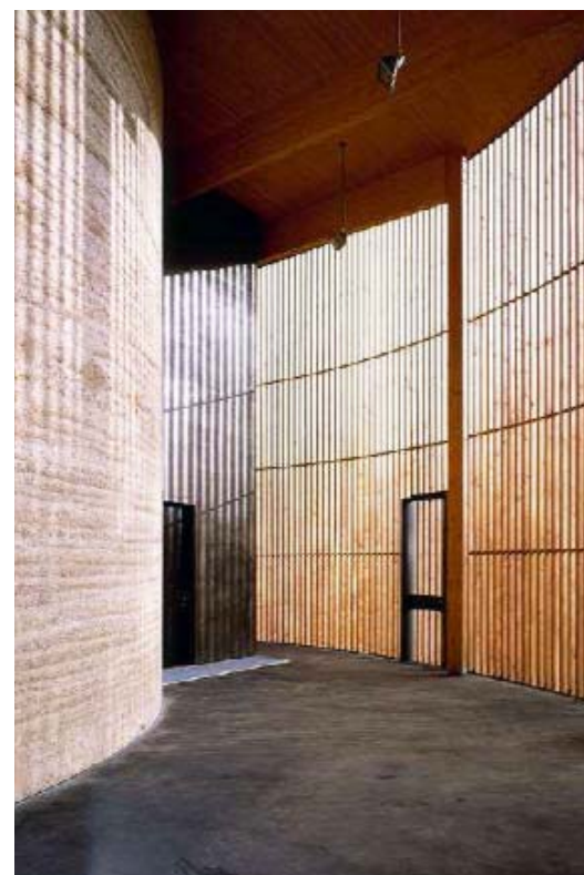
La cappella presenta due “gusci”. Dall'involucro esterno in lamelle di traspare il nucleo strutturale realizzato con 390 tonnellate di terra proveniente dalla periferia della città impastata con i laterizi frantumati provenienti dalla vecchia costruzione.
