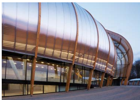
Foto in copertina La Zénith Concert Hall di Limoges (F) Foto: Christian Richters per Tschumi Architects
