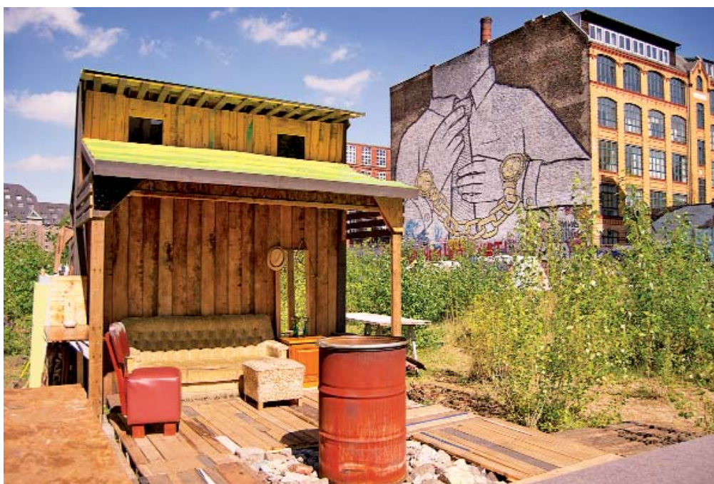
La piccola casa di legno di Cuvry Strasse nella zona di Berlino est, realizzata in autocostruzione con materiali riciclati, progettata da Chiara Ciccarello e Yukihiro Taguchi.
