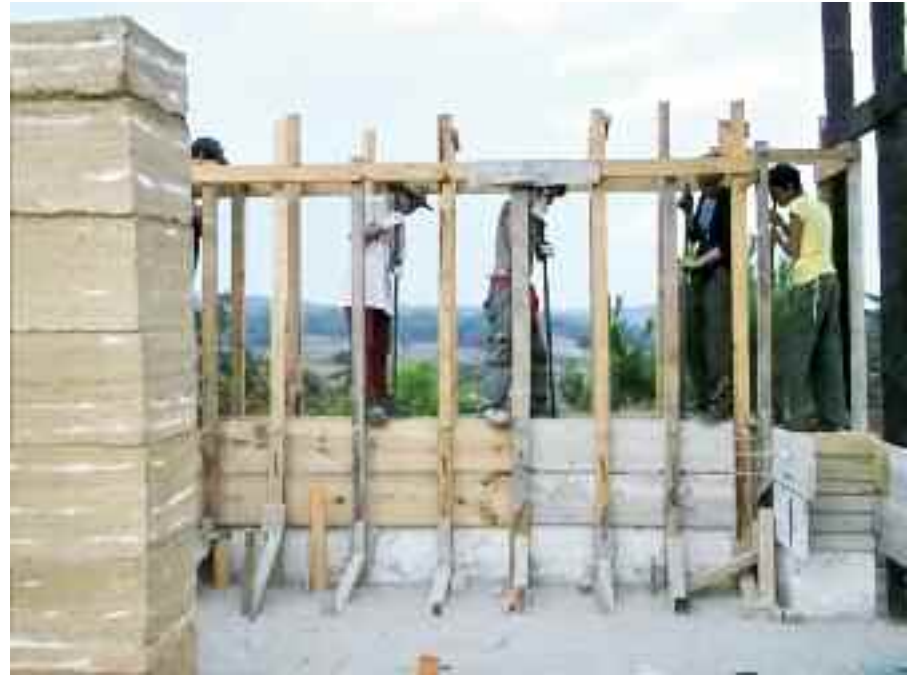
La battitura della terra cruda nella realizzazione delle pareti della cucina. In basso, il cantiere dei lavori con la grande parete in legno e bambù per l'aula all'aperto e il blocco in terra. Nella pagina accanto, il progetto dei casseri, realizzato appositamente, per la costruzione dei muri in terra cruda battuta.
