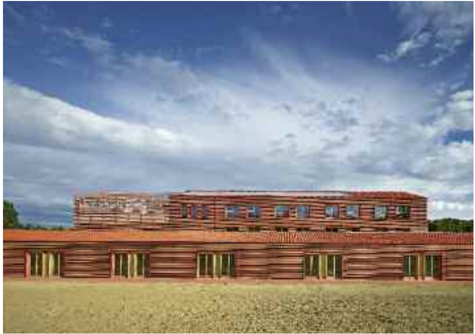
I brise-soleil in cotto paglierino disegnano le pareti semi-ventilate, in grado di fornire una bicromia che era specificatamente richiesta dal bando come requisito cogente.
